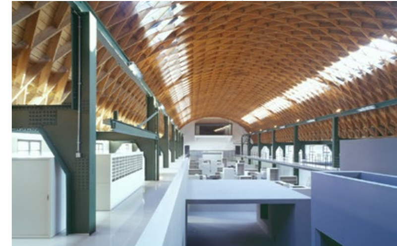
Die Zollinger Halle mit ihrer einzigartigen und denkmalgeschützten Holzdeckenkonstruktion ist eines der Highlights auf dem Areal.
